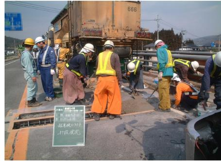
超速硬コンクリート打設
