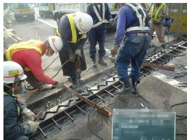
差し筋アンカー穿孔打込状況
