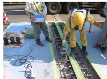
コンクリート打継接着剤使用状況
